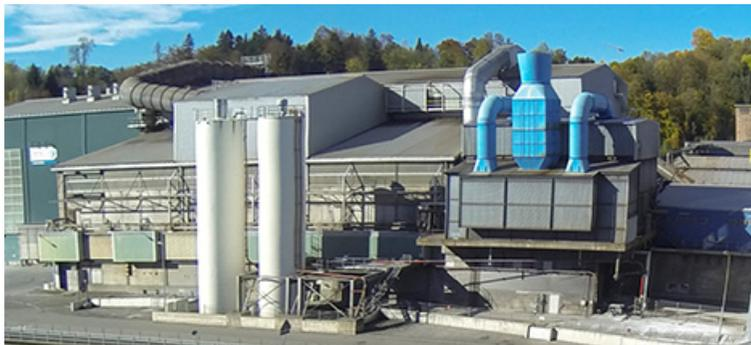
Filtersystem Hallenabsaugung im Stahlwerk (CHF 4,6 Mio.)
